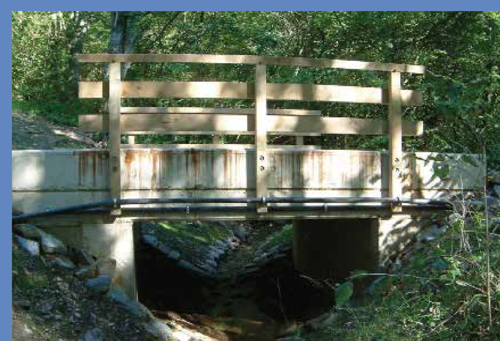
Neu angelegte Brücke mit fortgeführtem Ufersaum. Das Gewässer ist für Tiere vollständig durchwanderbar
