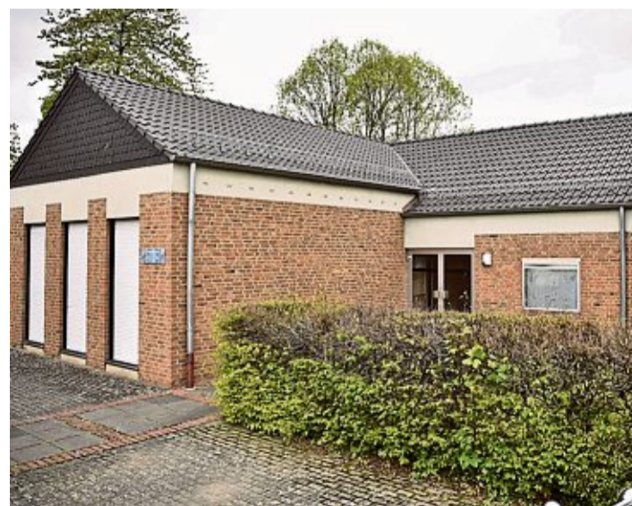
Abgerissen wird das alte Pfarrheim in Sinzenich, damit an dieser Stelle die neue zweigruppige Kita entstehen kann. Foto: Julia Reuß
