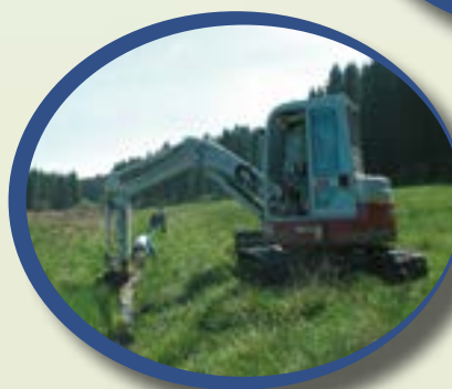
Ein Bagger im Einsatz zur Beseitigung von Ufer- und Sohlverbau
