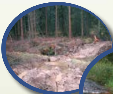
Durch unbefestigte Furten gelangen Feinsedimente in die Bäche. Deswegen wurden die Bachdurchfahrten entweder befestigt...
